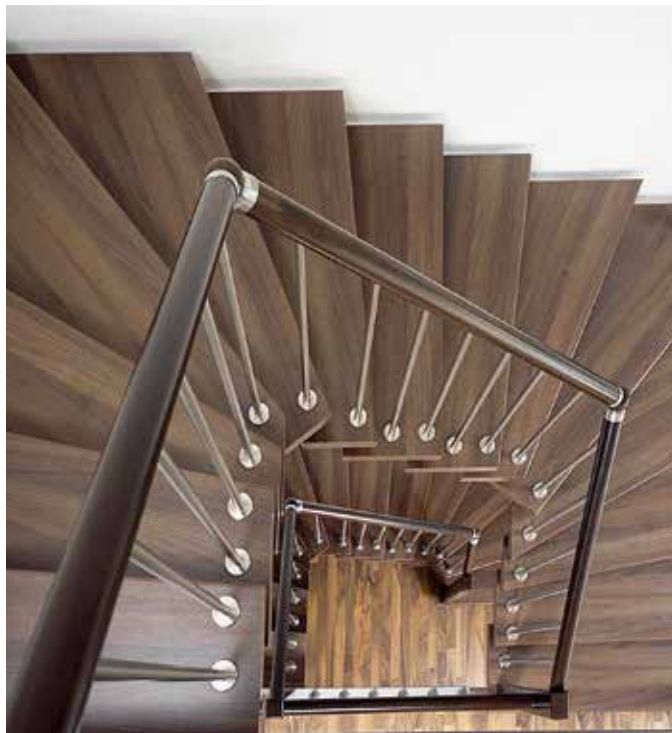
Abb.: Griffsicherer Rundhandlauf Dabei sollte der horizontale Profildurchmesser 4 bis 6 cm betragen.
