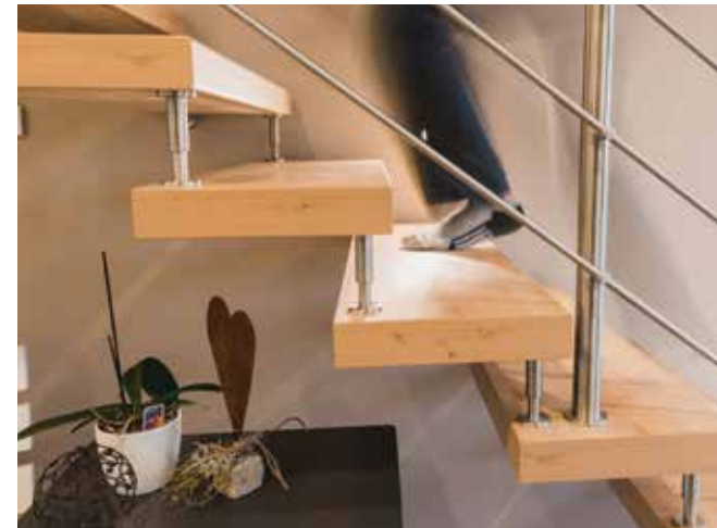
Abb.: „Strümpfig“: Rutschhemmende Stufenoberfläche vermindert Unfälle. KENNGOTT-TREPPEN bietet durch LONGLIFE Oberfläche die Rutschfestigkeit R9 für den Innenbereich an.
